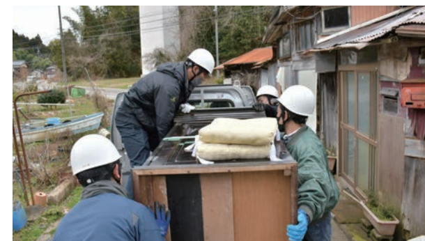
男子部の有志による清掃ボランティア「かたし隊」が、能登半島地震の被災地で復旧作業 (2月、石川)
